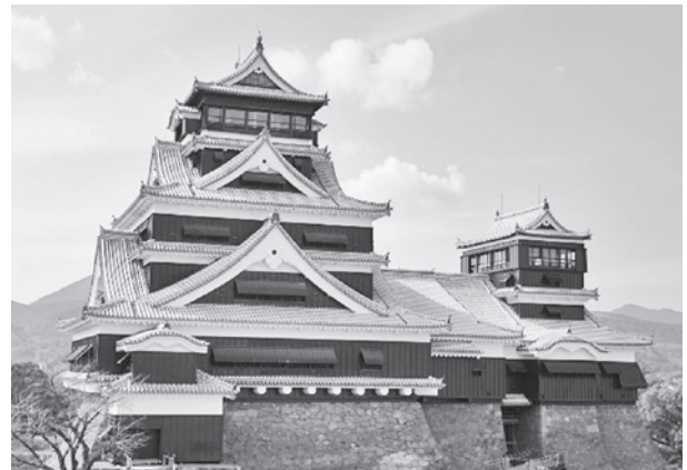
熊本城天守閣（復旧後）
